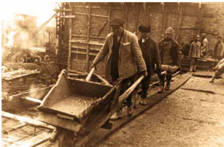
На будівництві ДніпроГЕСу
