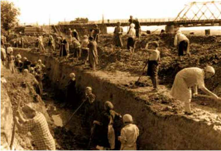
Будівництво протитанкових укріплень (1941 рік)
