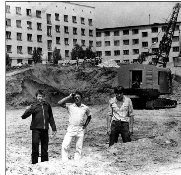
1982 рік. Початок будівельних робіт на місці сучасного спорткомплексу Інституту фізичної культури
