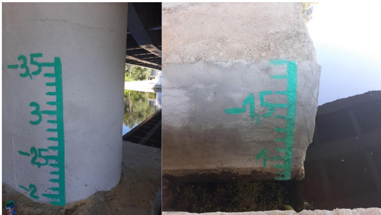
Рис. 3.2.1.1. Рейковий гідрологічний пост (створ № 2 – с. Климентово) (19.08.20 р.)
