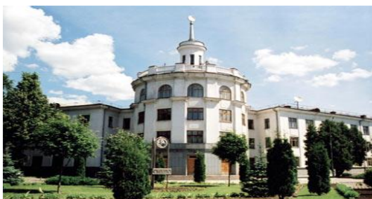
Der administrative Bau der offenen Aktiengesellschaft "Sumy M.V.Frunze – Maschinenbauwerk"
